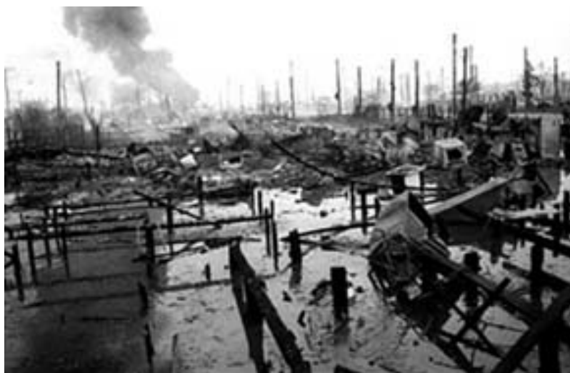
Figura 1: Incêndio em Vila Socó – Cubatão: vazamento de 700 mil litros de gasolina de um dos dutos que atravessam o local – 2/1984
